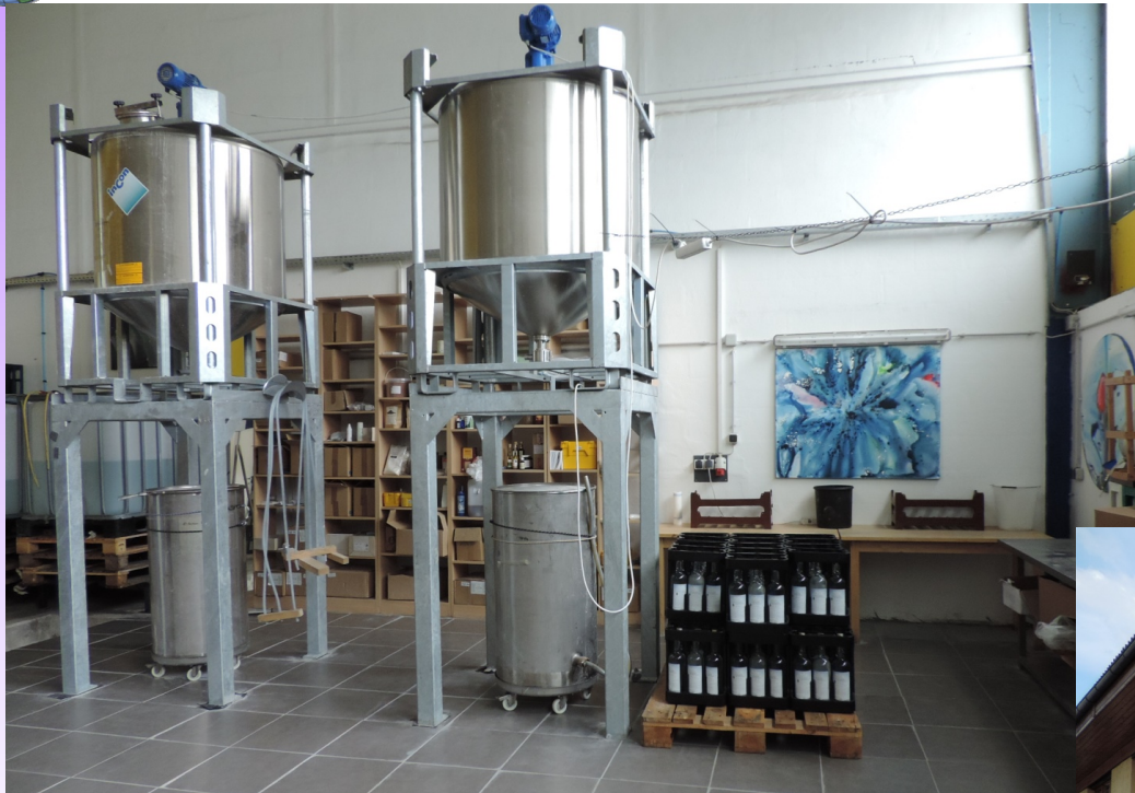
Stahltanks mit Rührwerk und Absetztanks.
